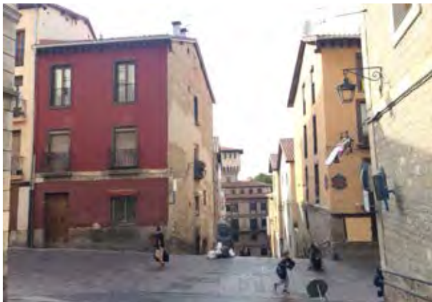
Le bâtiment dans son contexte urbain.
