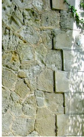
Figure 34 - Pont de Leingary : détail des maçonnerie de moellons en opus incertum, et pierre de taille. Photo N. D.
