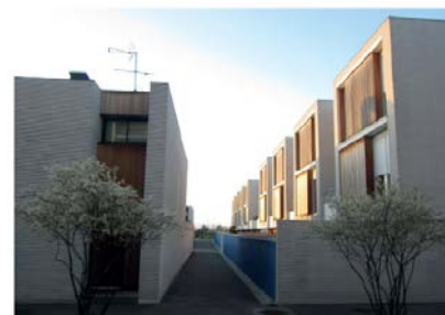
VUE SUR LA VENELLE OUEST, SÉPARATION ENTRE LES LOGEMENTS INDIVIDUELS ET LES LOGEMENTS GROUPÉS
