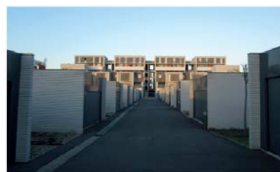
VUE DEPUIS LA VENELLE CENTRALE
