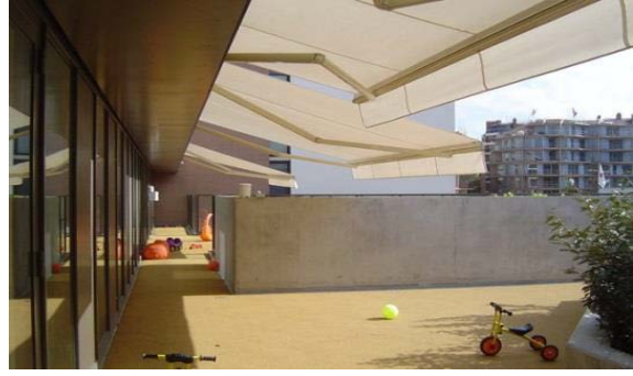
Figure 31 : Protections solaires (Cabinet de conseil Utopies, 2007)
